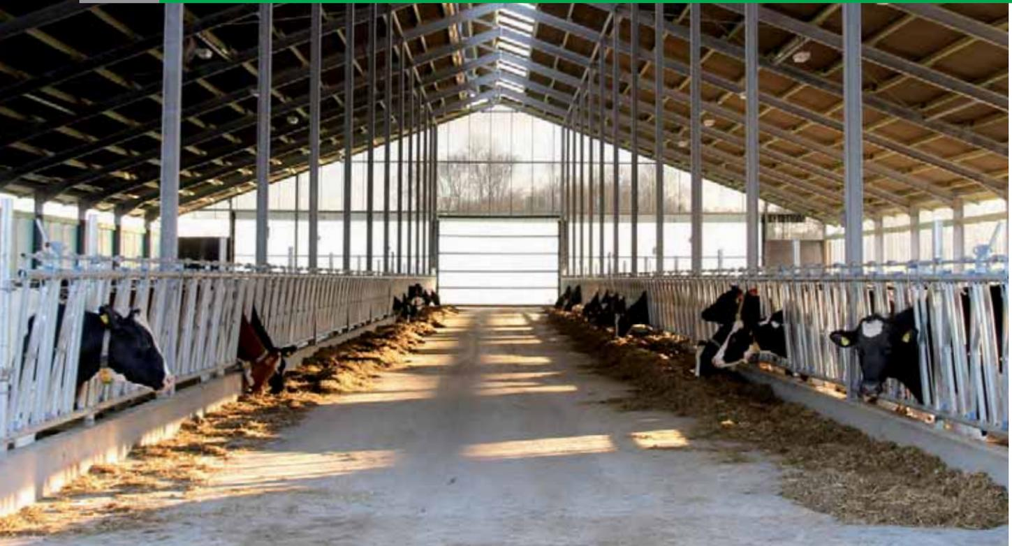
Tore mit Geweben sind besonders leicht und trotzdem stabil. Mit der richtigen Wahl des Gewebes lassen sich zusätzlich Lüftungseffekte realisieren. Die Tore öffnen grundsätzlich von unten nach oben. Es werden verschiedene Torvarianten angeboten: mit Handwinde/elektrisch, mit/ohne seitlicher Führung oder mit/ohne aussteifenden Querstreben.
