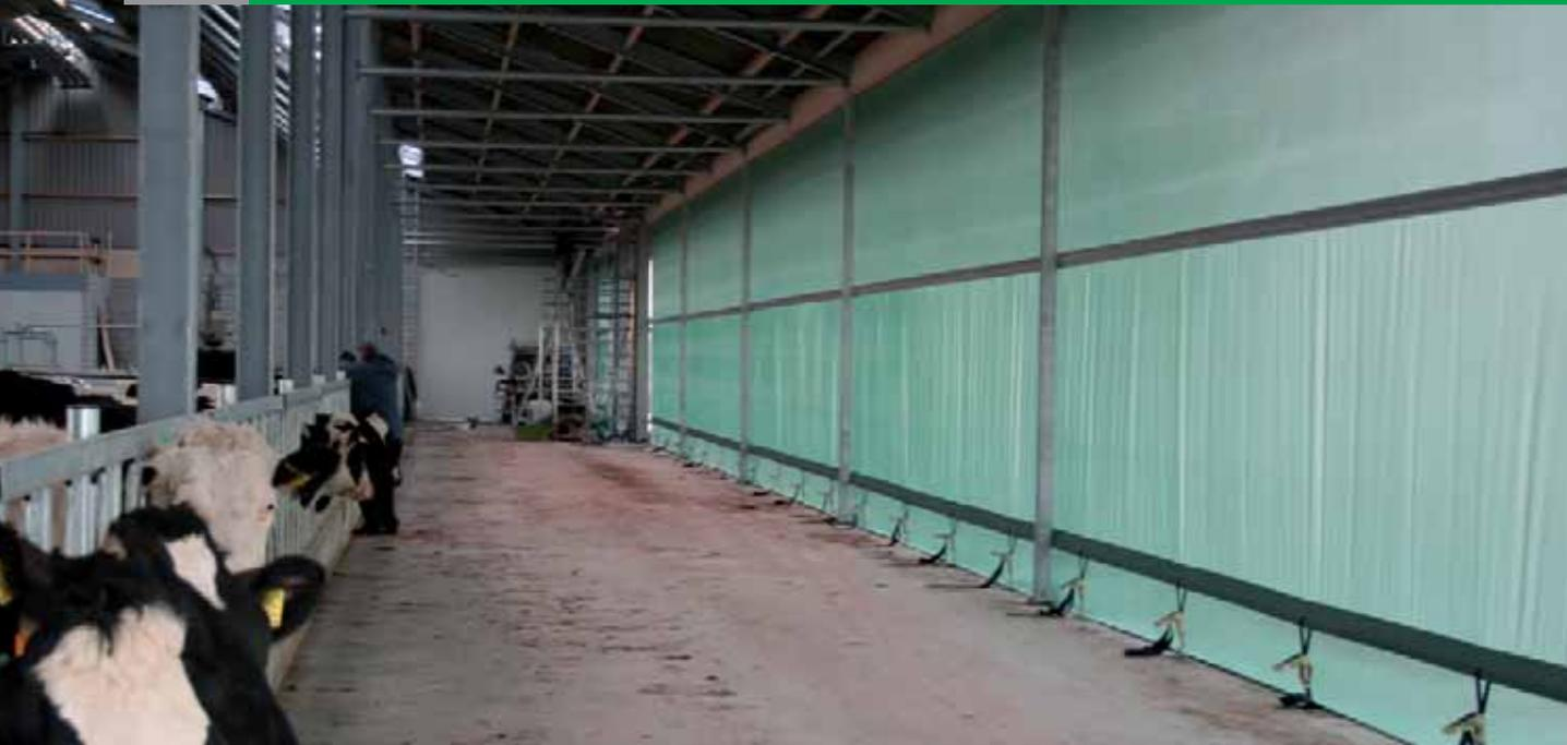
Fronten dienen dem Windschutz und verschließen größere Durchfahrten als normale Tore. Im geschlossenen Zustand werden sie mit Ratschen verspannt und bilden einen effektiven Wind- und Wetterschutz. Es wird unterschieden zwischen Systemen zum Rollen oder Falten, nach oben oder seitlich öffnend.
